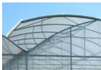
Finestra singola di colmo 50% Single 50% roof vent
