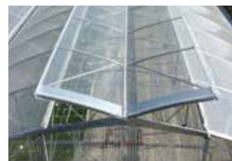
Finestra doppia di colmo Double (butterfly) roof vent
