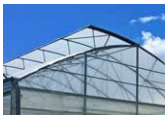
Finestra singola di colmo Single roof vent
