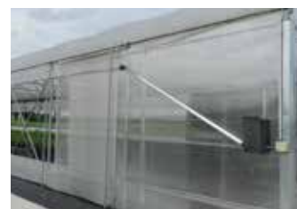
Braccio cardanico telescopico automatico Motor-driven telescopic arm
