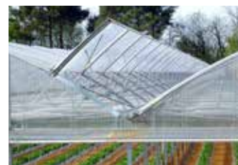
Finestra singola di gronda Single gutter vent
