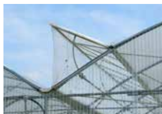
Finestra singola di gronda Gutter single vent
