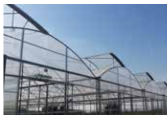
Finestra singola di colmo Single roof vent
