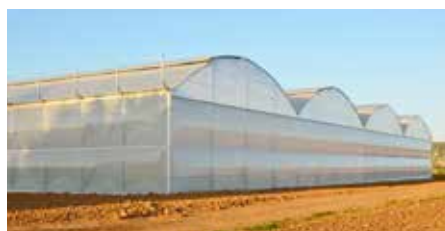
Rivestimento frontale in doppia parete Double layer frontal cladding
