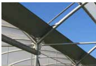
Finestra avvolgibile di colmo Roller roof vent
